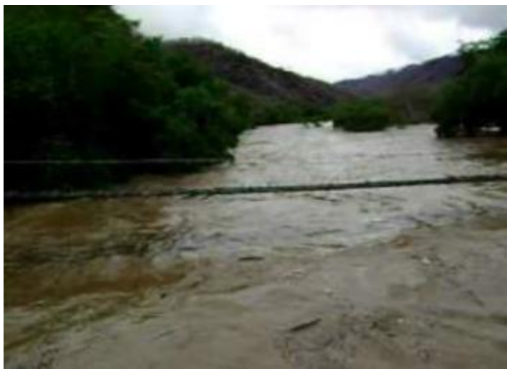
Imagen 6. -Puente vehicular inundado en Tiquicheo, imposibilitando el acceso y salida del lugar en riesgo. Fuente: "Inundación de Tiquicheo", Veengle, Edición Electrónica 2012, En [ http://goo.gl/Cec1OC ], febrero 05,2013.
