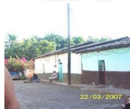
Imagen 35.- Tiquicheo cercas del límite de la localidad, Vivienda de tipo 8, acuerdo al CENAPRED y a su base en los puntos débiles de una vivienda ante la acción de sismo, fuente: en línea en [ http://goo.gl/HDGhLb ], septiembre 2013.
