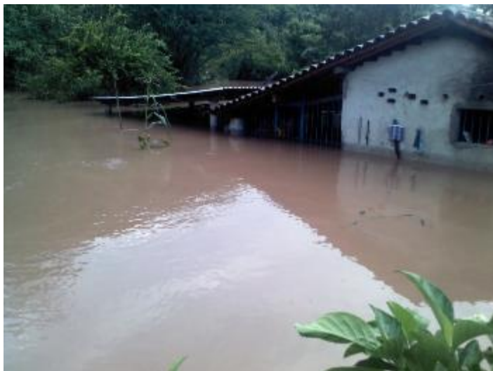
Imagen 130.- Fotografía que muestra el nivel de agua alcanzado al pasado 22 de septiembre del 2013 a causa del desbordamiento del río Purungueo, foto: H. Ayuntamiento de Tiquicheo.
