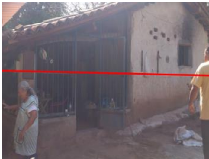
Imagen 131.- Así luce la vivienda de la Localidad de Piedra China después de la inundación del 22 de septiembre del 2013, con un nivel alcanzado de 2 mts., de altura, Fuente: Edgar Palomino.
