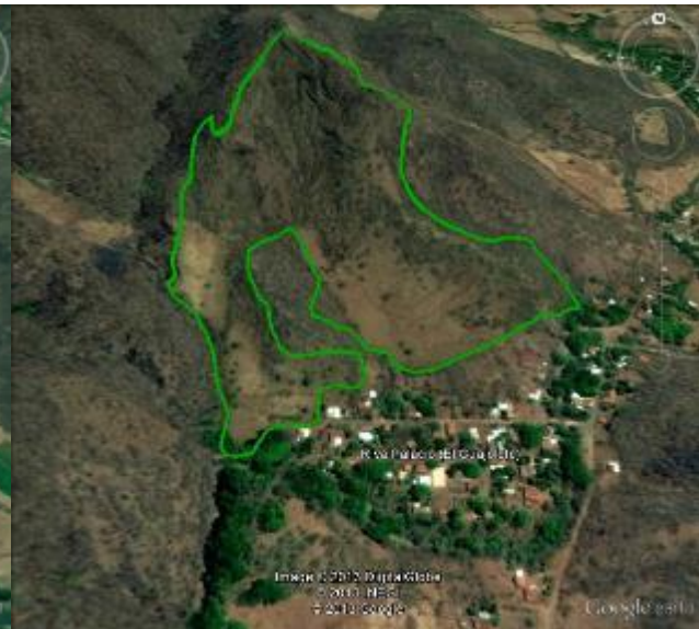
Imagen 55.- Imagen satelital cerca de la localidad de Riva palacio, la cual presente un deslizamiento Translacional, Fuente: Cruden y Varnes 1996 [imagen satelital Google Earth 2013], septiembre 2013.
