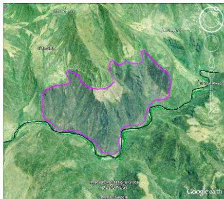
Imagen 48.- Deslizamiento Rotacional, cerca de las localidades de El Timbillo, El Pinzón Morado y los Lampazos. Fuente: Cruden y Varnes 1996 [imagen satelital Google Earth 2013], septiembre 2013.
