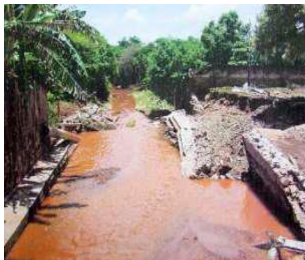
Imagen 4.- Daños causados por las lluvias en Tiquicheo. Fuente: La Jornada Michoacán, Edición Electrónica, En [http://goo.gl/7VHDGK], febrero 06, 2013.
