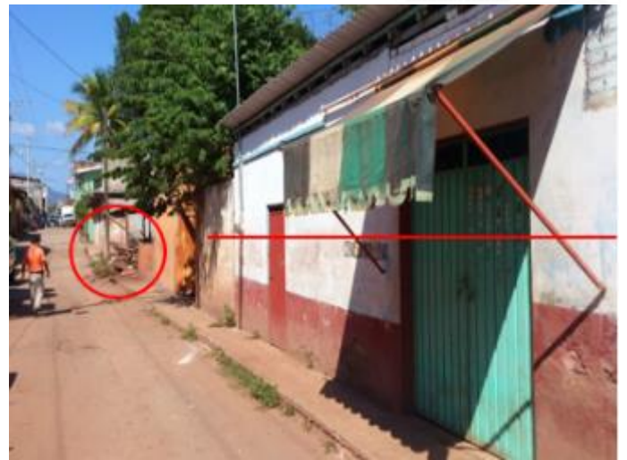
Imagen 121.- Calle de la localidad de Tiquicheo y su contexto después de los estragos de la inundación del pasado 21 de septiembre del 2013, Fuente: Edgar Palomino.
