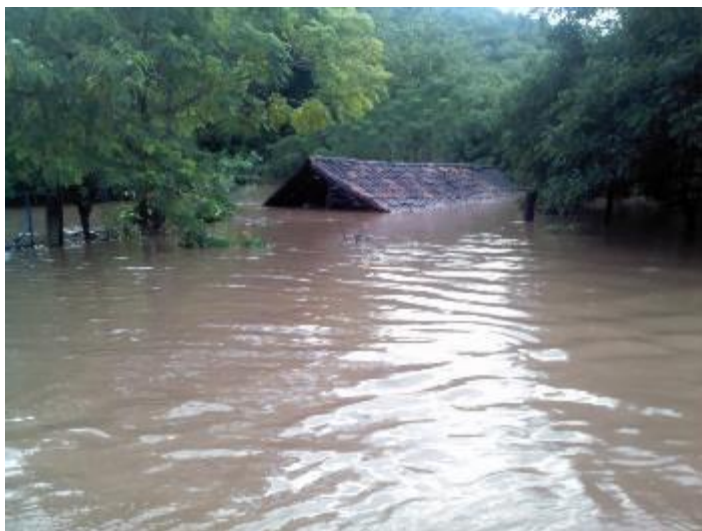
Imagen 132.- Varias viviendas terminaron bajo el agua en la localidad de Piedra China, debido al desbordamiento del río Purungueo, foto: H. Ayuntamiento de Tiquicheo.
