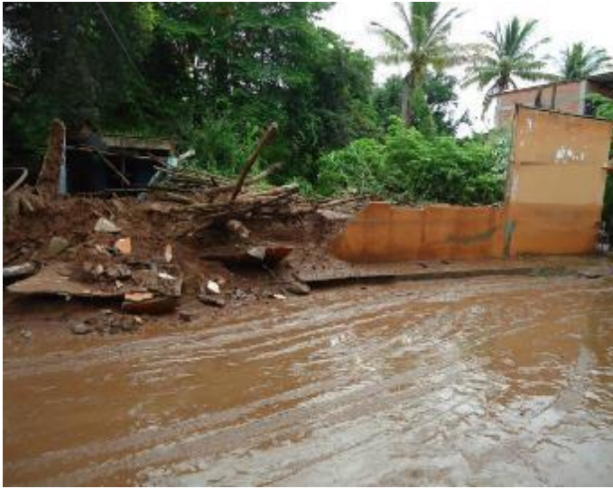
Imagen 61.- Imagen de la localidad de Piedra China, daños causados por lluvias pasadas en el mes de septiembre del 2013. Foto: H. Ayuntamiento de Tiquicheo, fuente: En Línea en [ http://goo.gl/azy2CH ], septiembre 2013.
